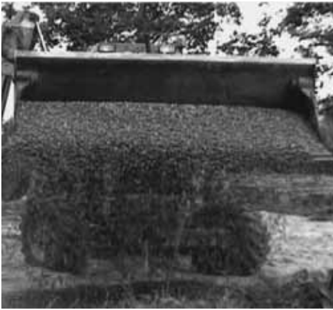
Der Bagger schüttet den Kies für den Rand auf, und dann wird er verteilt
