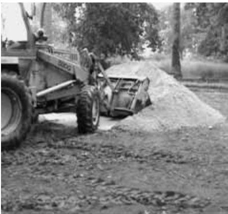
und vom Schaufelbagger auf dem Gelände verteilt und von Hand begradigt
