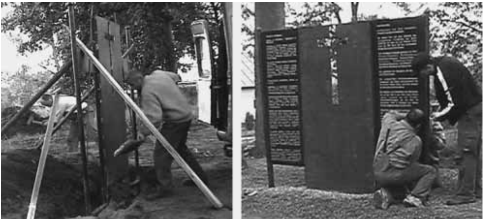
Die Gedenktafel wird einzementiert und die Schrifttafeln werden fixiert
