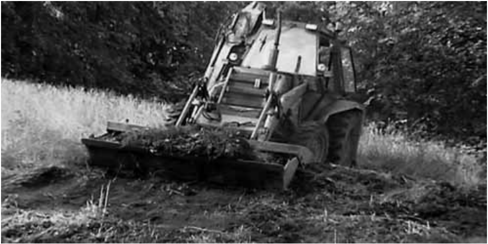
Als Erstes wird die oberste Schicht abgetragen und begradigt
