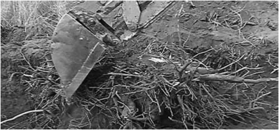
Der ausgegrabene Baumstumpf wird nun „klein gemacht“
