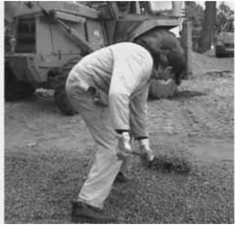
Der Bagger schüttet den Kies für den Rand auf, und dann wird er verteilt
