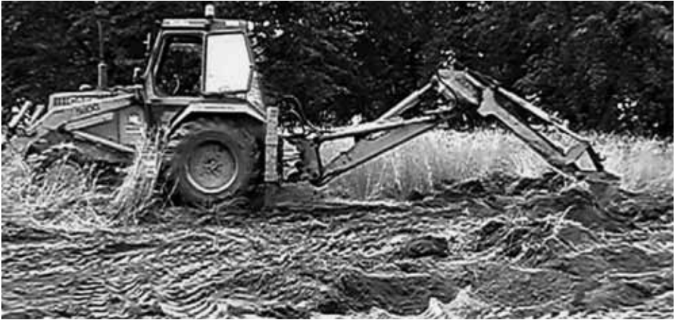
Der Schaufelbagger muß alte Baumstümpfe ausgraben
