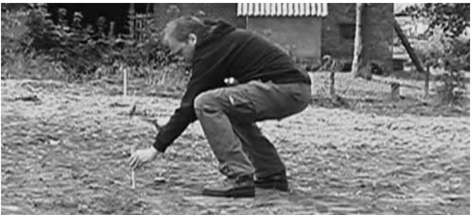
Das Gelände wurde vermessen und Holzpflocke werden zur Orientierung für die folgenden Installationen gesetzt
